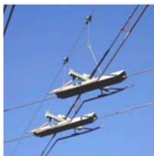
Abbildung 18. Kreuzung Obus/Straßenbahn ohne Stromunterbrechung
